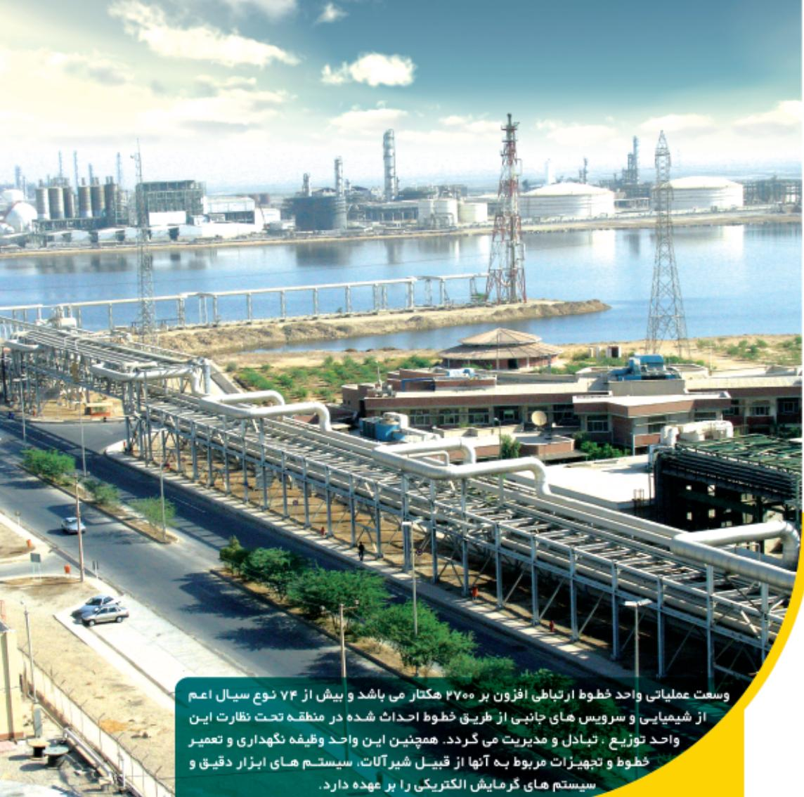
و سعت عملیاتی واحد خطوط ارتباطی افزون بـ ۲۷۰۰ هکتار می باشد و بیش از ۷۴ نوع سیال اعم از شیمیایی و سرویس های جانبی از طریق خطوط احداث شده در منطقه تحت نظرت این واحد توزیع ، تبادل و مدیریت می گردد. همچنین این واحد وظیفه نگهداری و تعمیر خطوط و تجهیزات مربوط به آنها از قبیل شیرآلات، سیستم های ابزار دقیق و سیستم های گرمایش الکتریکی را بر عهده دارد.
